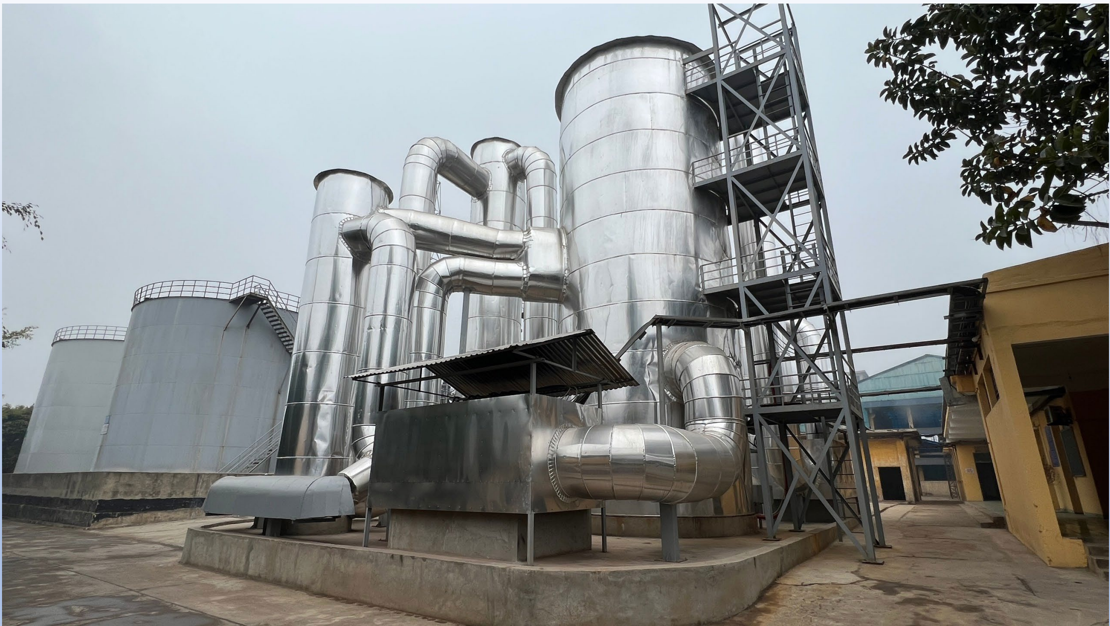
Xây dựng mới Tháp chuyển hóa HM A10 tại Nhà máy điện phân Kẽm Thái Nguyên. New construction of HM A10 conversion tower at Thai Nguyen Zinc Electrolysis Factory.
